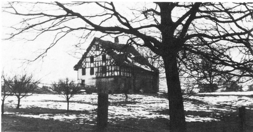
Wirtschaft auf der Heel (Aufnahme 1969), im Oktober 1971 bei einer Luftschutzübung abgerissen. Das Haus stand dort, wo jetzt die Reihenhäuser an der Unterrenngstrasse gebaut werden (im Vordergrund ein Nussbaum der Liegenschaft Koller).
